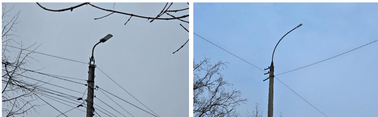
Figura 13. Iluminat public cu corpuri de iluminat LED în municipiul Soroca
